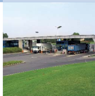
Ricevimento rifiuti in ingresso
