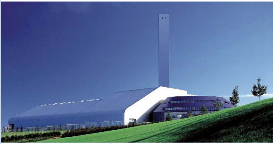
Vista lato Nord-Ovest
